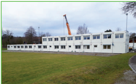
Schulcontainer des Einrichtungsverbands Steinhöring (EVS). (Foto: Architekturbüro Einhellig)
