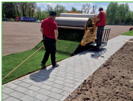
Rollrasenverlegung durch die Schwab Rollrasen GmbH (Foto: John GmbH)
