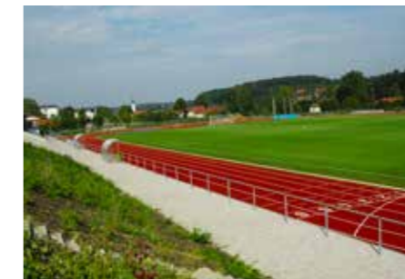
Perfekte Ausführung der Gesamtanlage.
