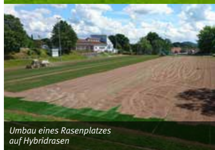
Die verlegten Kunstfasern zur Verstärkung der Rasentragschicht
