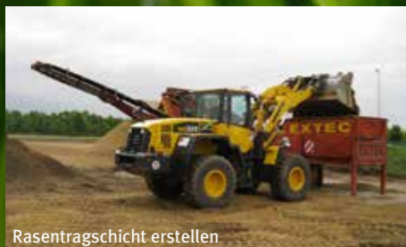
Rasentragschicht erstellen
