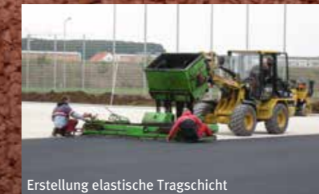
Erstellung elastische Tragschicht
