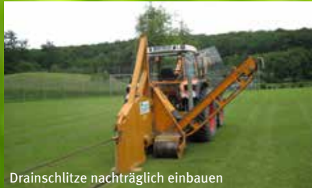
Drainschlitz nachträglich einbauen
