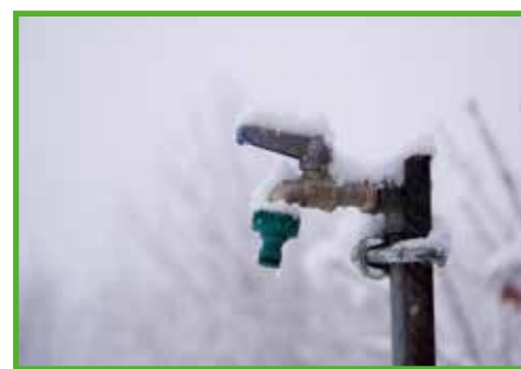
Bild 5: Wasserleitungen entleeren und sperren
