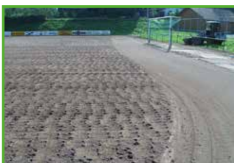
Bild 5: „Verzahnen“ der Deckschicht mit der dynam. Schicht
