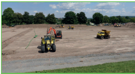
Ziehen rohrloser Drainschlitzte. (Foto: John GmbH)
