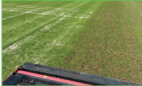
Besandungs- und Lockerungsmaßnahmen zur Optimierung der Ebenflächigkeit und Durchlässigkeit. (Foto: Schmitt Sportplatzbau)
